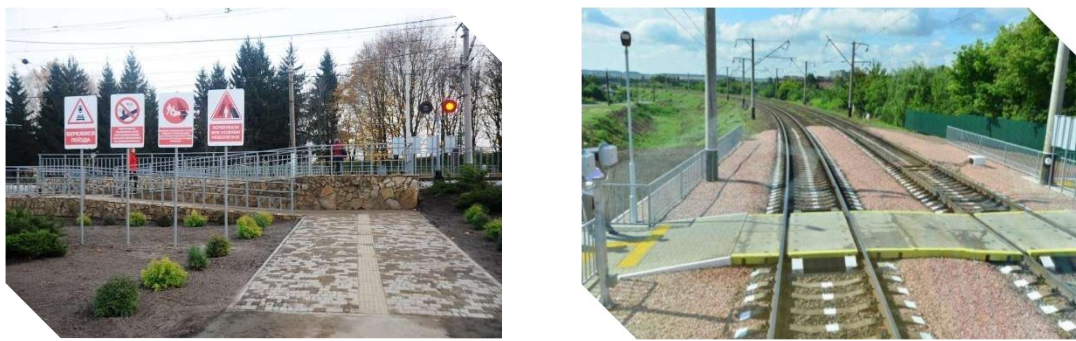
Рис. 2. Влаштований залізничний пішохідний перехід в одному рівні із залізничними коліями на Львівській залізниці [4]
